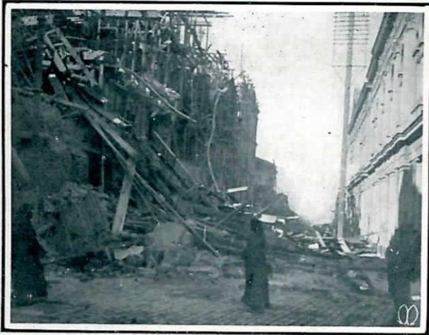
Plaza Victoria.—Esquina Chacabuco
